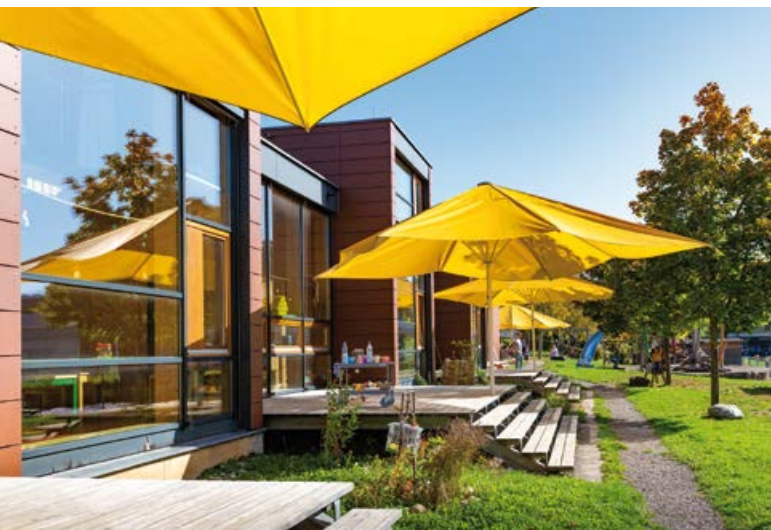
Außenbereich des Kinderhauses in Geradstetten
