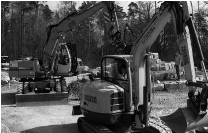
Die Ausbildung von Baugeräteführern ist ein Schwerpunkt des Bildungszentrums Geradstetten. Bildnachweis: Bauwirtschaft Baden-Württemberg e.V.
