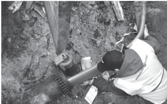
Der Schlauchliner dichtet das alte Wasserrohr von innen ab. (Bild: REMSTALWERK)
