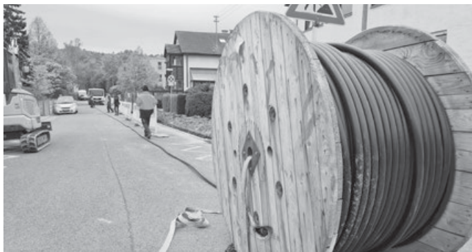
In der Fuhrbachstraße ist bereits ein neues Niederspannungskabel verlegt worden. (Bild: REMSTALWERK)
